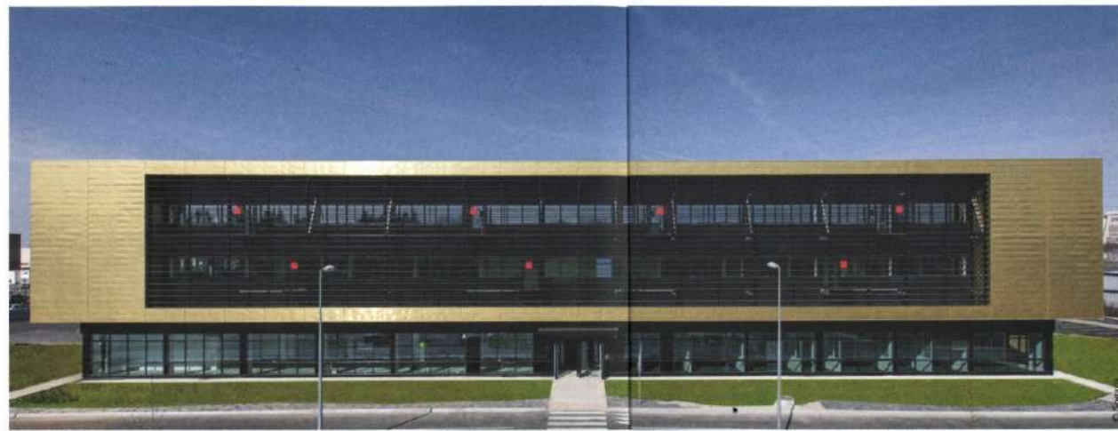
L'immeuble Sogaris, à Créteil, a fait l'objet d'une réhabilitation complète en 2015. L'objectif? Favoriser la modularité afin que le site puisse satisfaire différents utilisateurs et être divisible.
