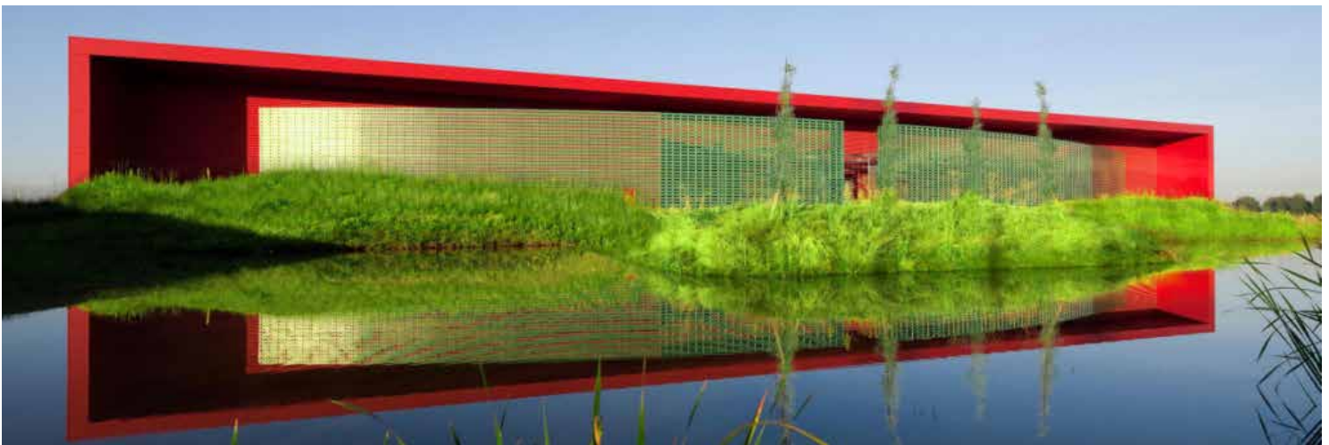
Panhard, Zac Les Haies Blanches au Coudray-Montceaux (91) - Parc Logistique - 186 800 m 2 (3 bâtiments) - Labels BREEAM et HQE
