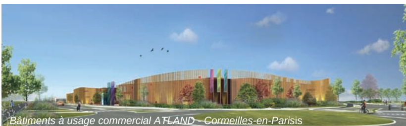
Bâtiments à usage commercial AFLAND - Cormeilles-en-Parisis
